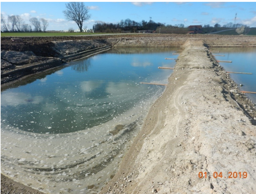
Figur 4.7 Bræmme med rør. Der kan også vælges beplantet bræmme.
