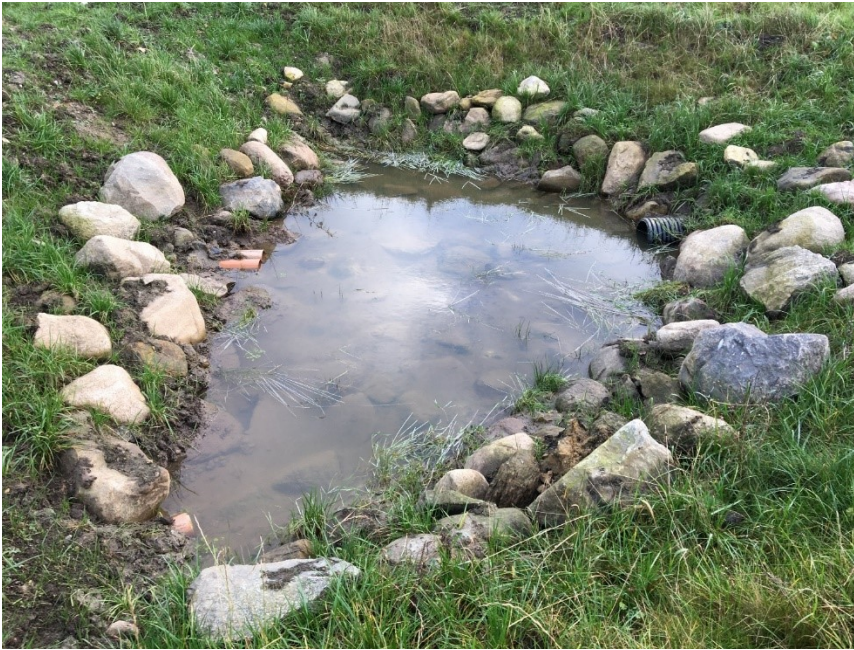
Figur 7.28 Iltningstrappe med ringe fald, men stadig godkendt.
