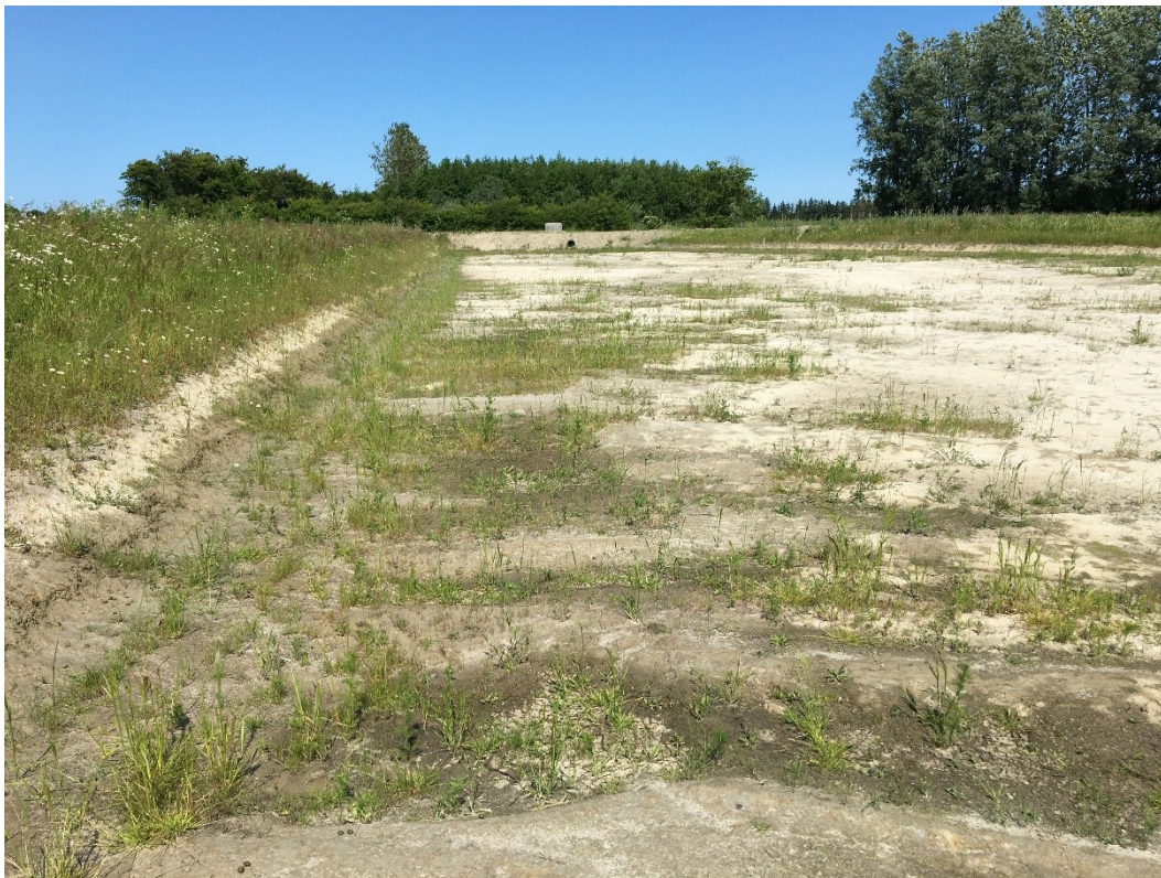
Figur 4.13 Minivådområdets bund (uden lermembran) før vandpåfyldning.
