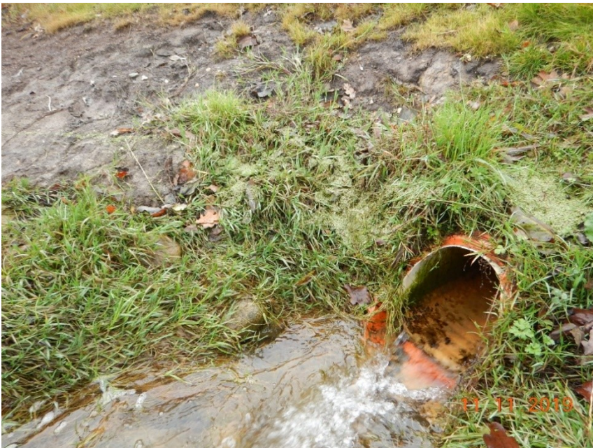
Figur 4.3 Drænrøret forsyner minivådområdet med vand.
