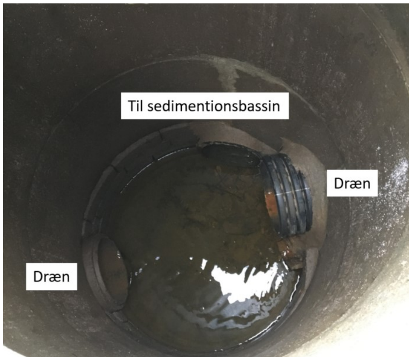
Figur 4.2 Drænrørene samles i en samlebrønd inden sedimentationsbassin
