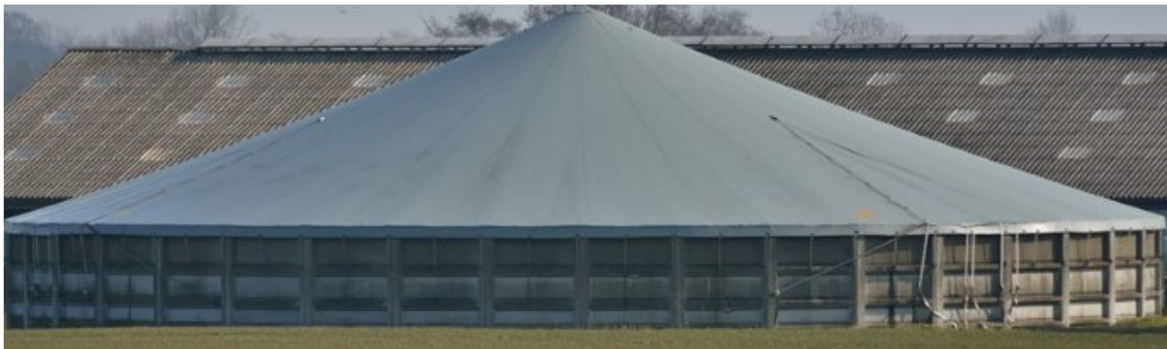
Teltoverdækning af gyllebeholder
